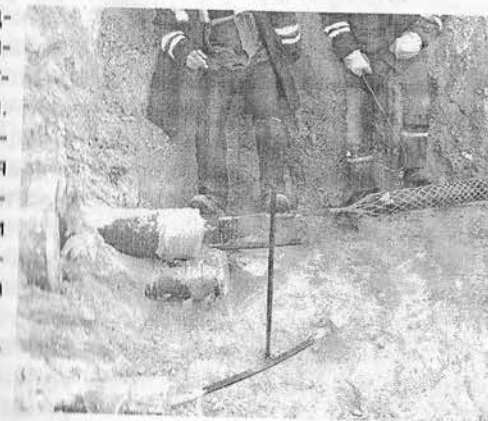
Рисунк 9.6 – Затягування кабелю в трубу
