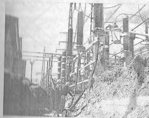
Рисунок 10.1 – Монтаж кінцевих кабельних муфт зовнішнього устаткування
