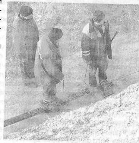
Рисунк 9.5 – Протягування кабелю в траншеї по роликах
