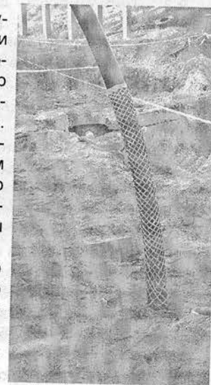
Рисунок 9.4 – Дрова панчоха для протягування кабелю
